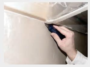
Bündiges Abschneiden des eingeputzten Dehnfugenbandes und Entfernen der Schutzfolie.
