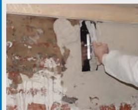
Verputzen der Oberfläche - das Dehnfugenband wird eingeputzt und bildet einen sicheren Putzanschluss.
