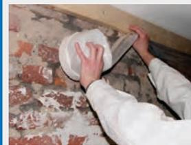
Abkleben des Putzanschlusses mit Dehnfugenband und Schutzfolie in einem Arbeitsgang
