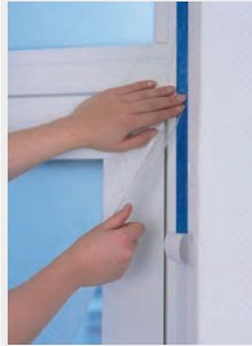
Bei den Maskenbändern ist kein Klebstoff an der Streichkante, so können Pinselborsten nicht festkleben. Zeit- und Kostenersparnis durch einfaches Entfernen des Kleberschutzpapiers.
